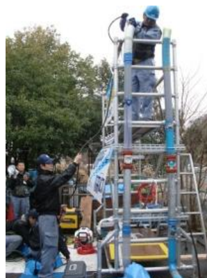
排水管更生工法「マルライナー工法」の見学会の様子
