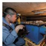
施工後の排水管内部と反転装置
